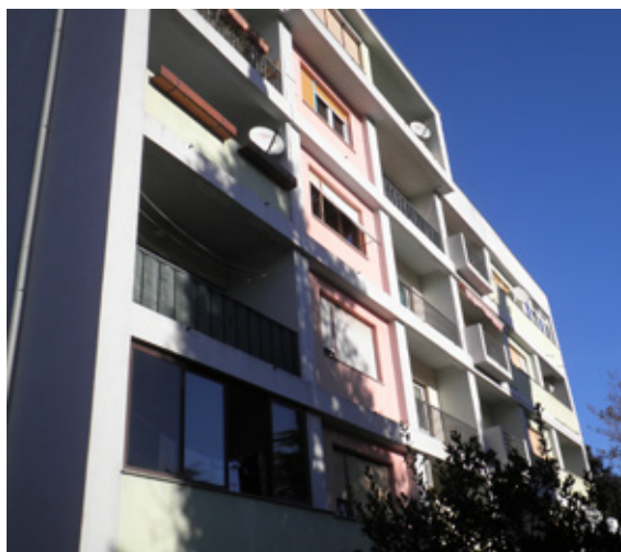
Slika 9: Zelenice 29, Labin – prije obnove (Izvor: Fond za zaštitu okoliša i energetska učinkovitost)
