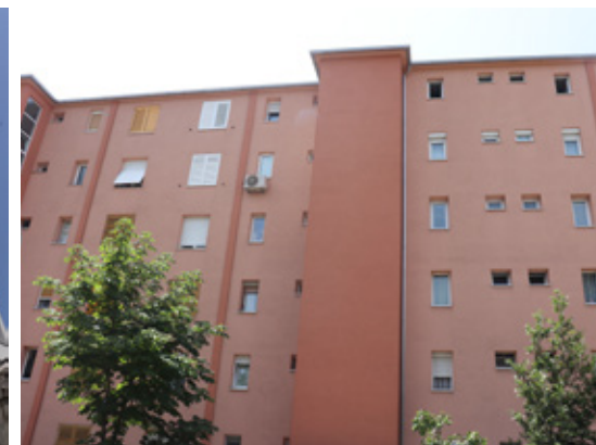
Slika 23 i Slika 24: obnovljene zgrade u Ulici Drage Gervaisa, Rijeka (izvor: Fond za zaštitu okoliša i energetska učinkovitost)
