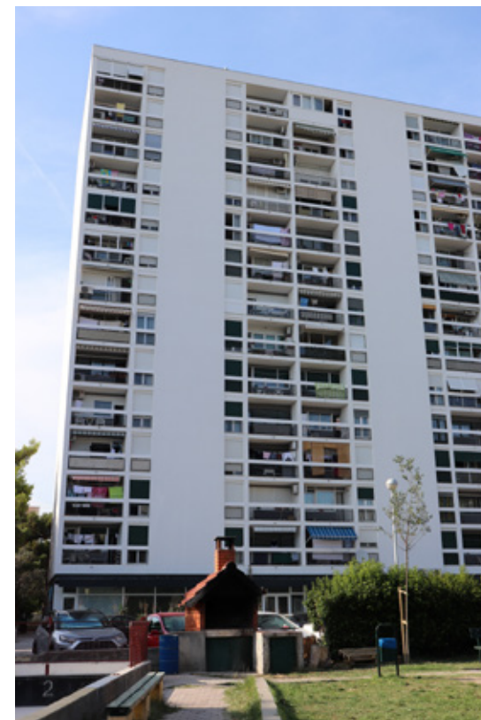
Slika 18: Stepinčeva 2 - 10, Split - nakon obnove (Izvor: Fond za zaštitu okoliša i energetske učinkovitost)
