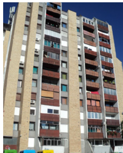
Slika 3: Sjenjak 101, Osijek - zgrada prije obnove (izvor: Krešimir Ižaković, predstavnik suvlasnika)
