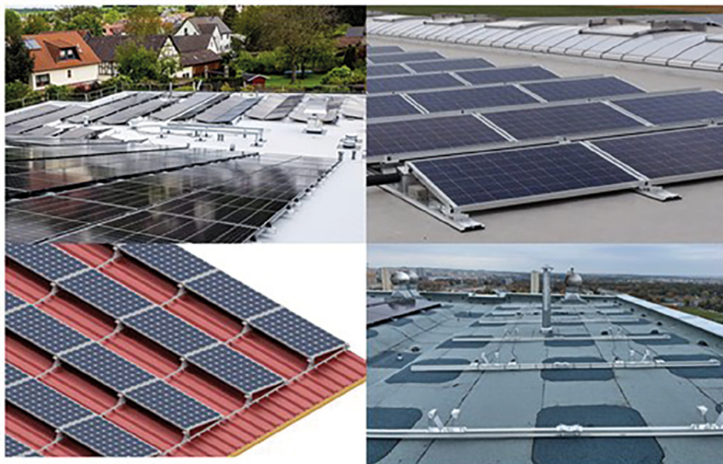
Rysunek 10-1 Przykładowe systemy montażu. Źródło: opracowanie własne.
