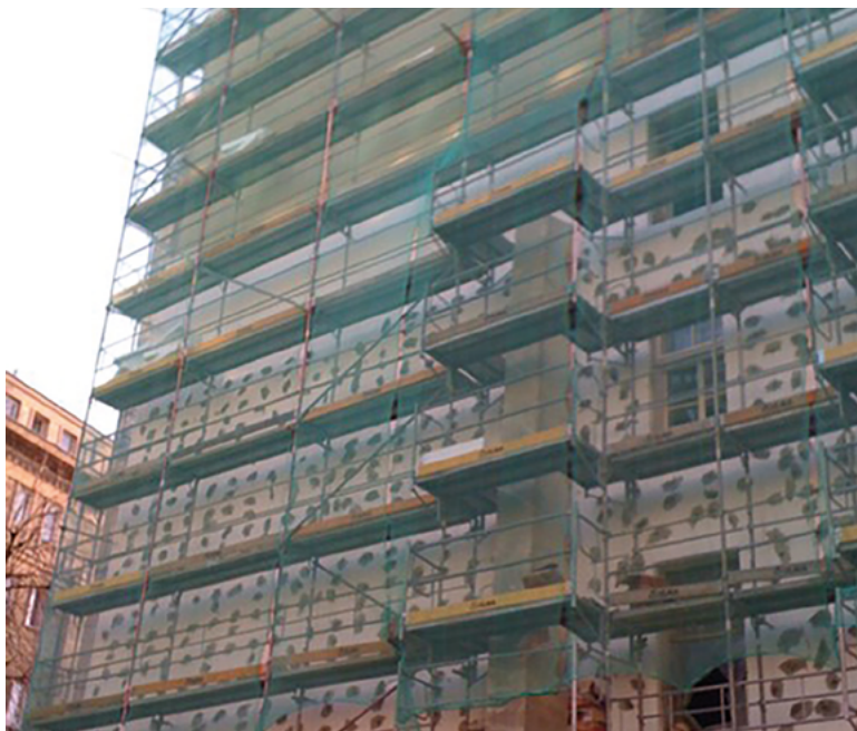
Rysunek 04-1 Ocieplenie budynku metodą lekką-mokrą (ETICS). Źródło: opracowanie własne.
