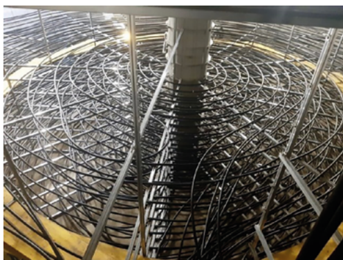
Rysunek 09-5 Wymiennik znajdujący się w magazynie energii. Źródło: opracowanie własne.
